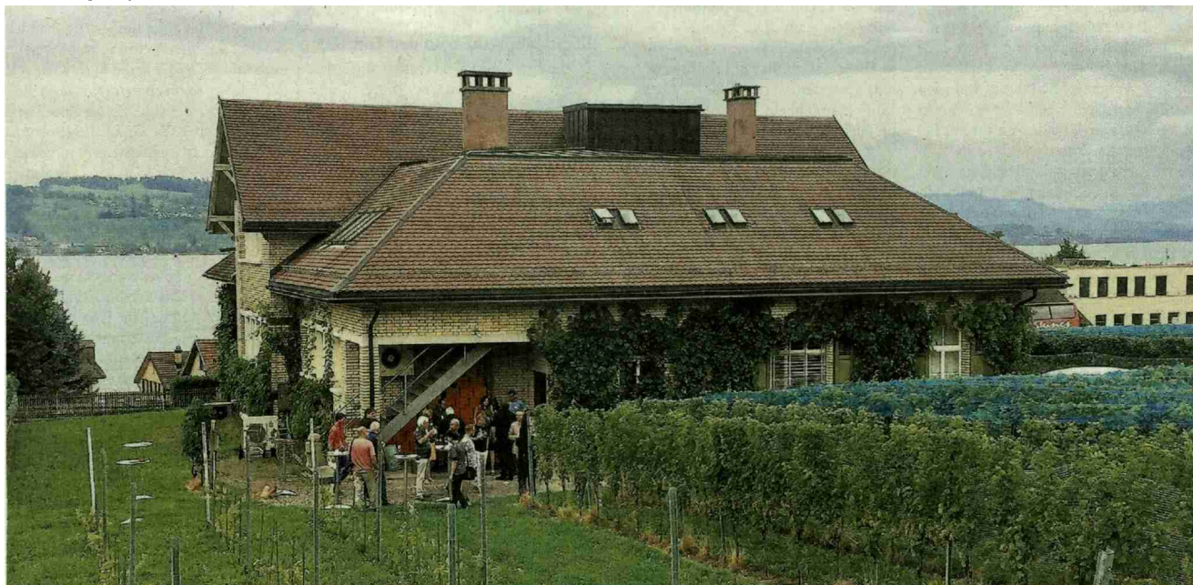
Im Keltereigebäude an der Schlossgasse in Wädenswil öffnet ab Januar 2018 das Deutschschweizer Weinbauzentrum. Themen wie die nachhaltige Produktion, der Strukturwandel oder das Marketing stehen im Fokus der Forschungsanstalt.
