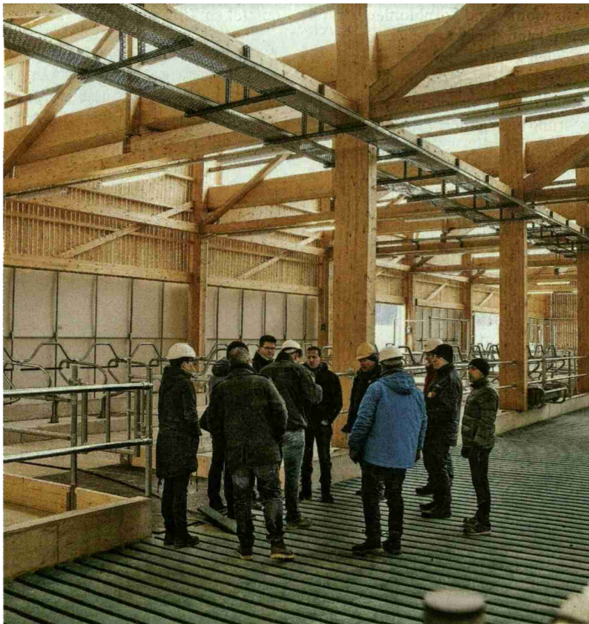
Agrovet-Strickhof: Bauabnahme der westlichen Hälfte des neuen Milchviehstalls am 13. Februar 2017. Bild: Strickhof
