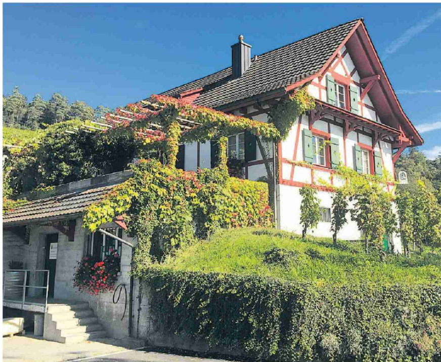
Weil die Fassade der Trotte unter Denkmalschutz steht, musste bei der Renovation mit äusserster Vorsicht vorgegangen werden. Bild: pd.
