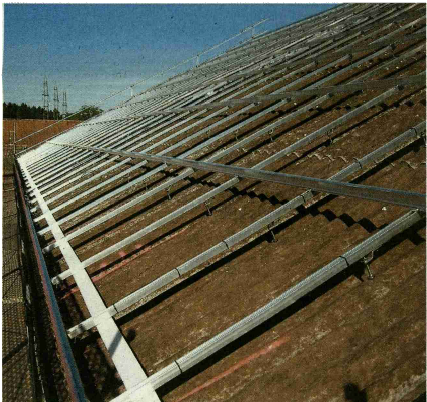
Solaranlage im Bau. (Bilder: Peter Hungerbühler)
