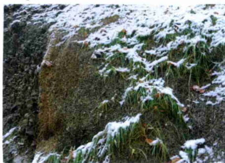
Die Vliesmatte hält die Nagelfluh zurück. (rb)
