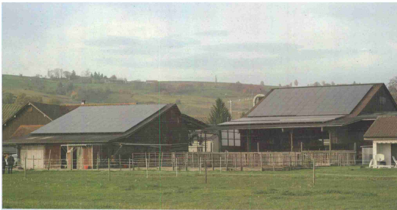
Die Solaranlagen auf den Dächern des Hofes des Oberhallauers Hansueli Graf gehen mit 42 Kilowattstunden ans Netz. Bild W. Schreiber
